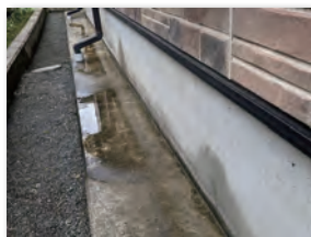
写真⑥ 雨が降っていないのに水がにじみ出ている
