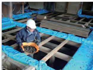
床下の泥をかき出す。必要なところは養生をする
