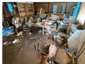
室内の被害状況も撮っておく
