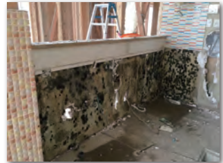
システムキッチンを外した裏側
